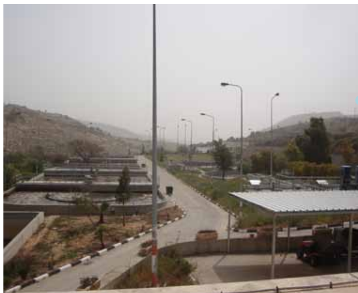
STATION D'AL BIREH 40 000 EH PRÈS DE RAMALLAH
