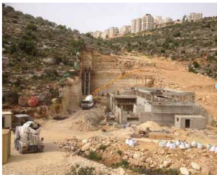
CONSTRUCTION DE LA STATION D'AL TIREH 25 000 EH À RAMALLAH
