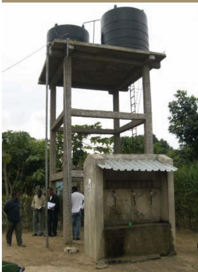
Photo 1. Château d'eau de POP
