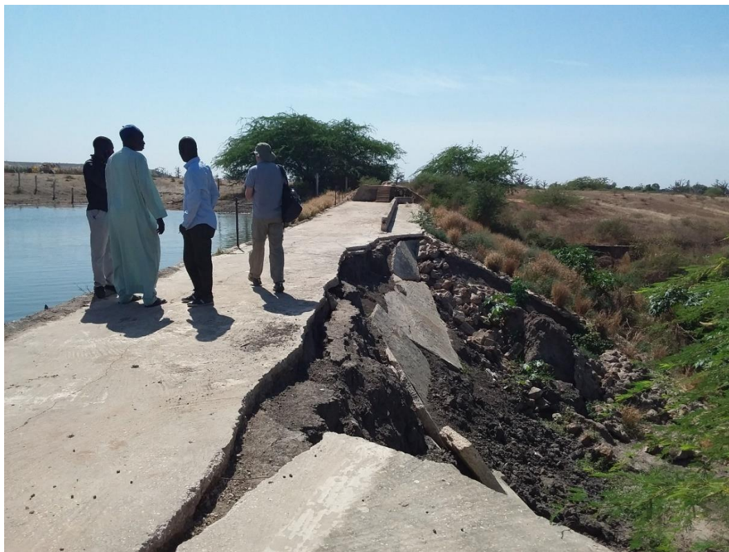
Figure 4-7. Bassin de rétention de Mont Rolland endommagé pendant une crue de la période hivernale de 2019.
