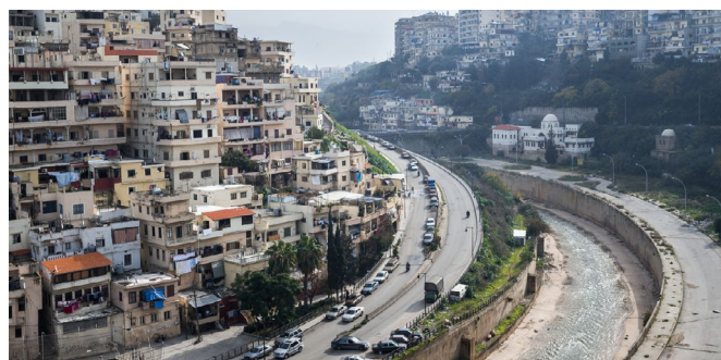
Au Liban, l'AFD a soutenu le développement de services et d'infrastructures d'eau et d'assainissement essentielles, notamment à Tripoli, première ville du pays qui dispose d'un accès à l'eau 24 heures sur 24 - © Benjamin Petit/AFD.
