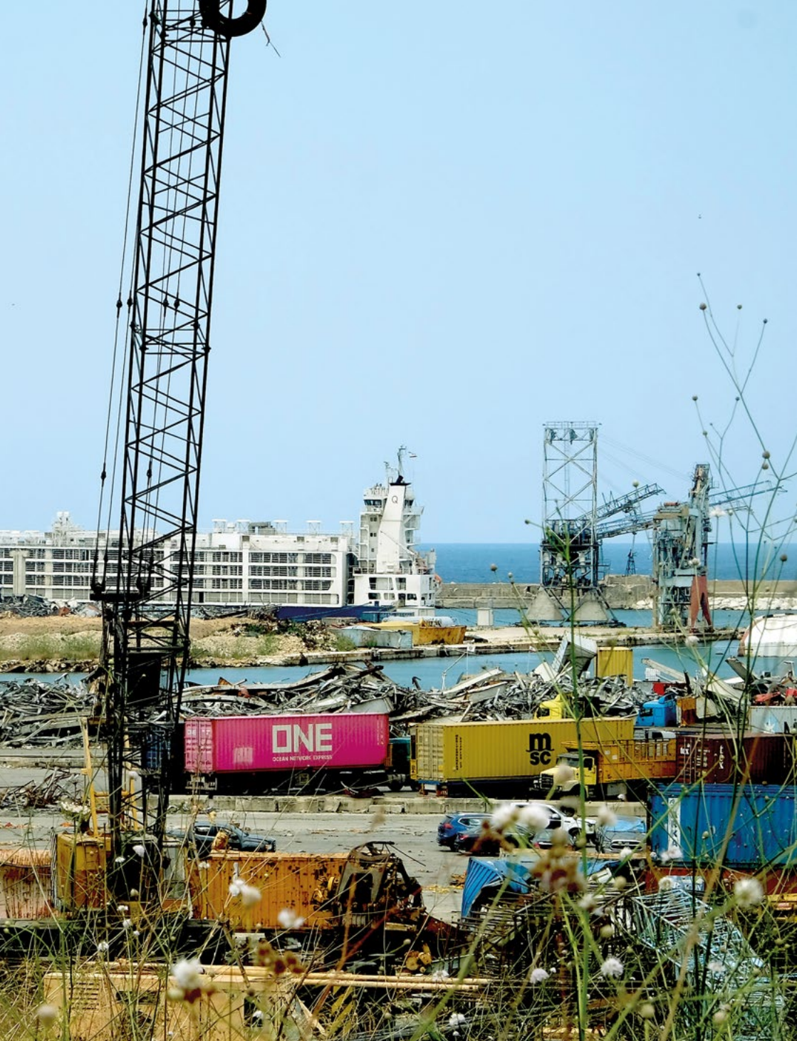
Le port de Beyrouth, quelques temps après l'explosion | © Marwa Kobeissi/ITAR Consultants
