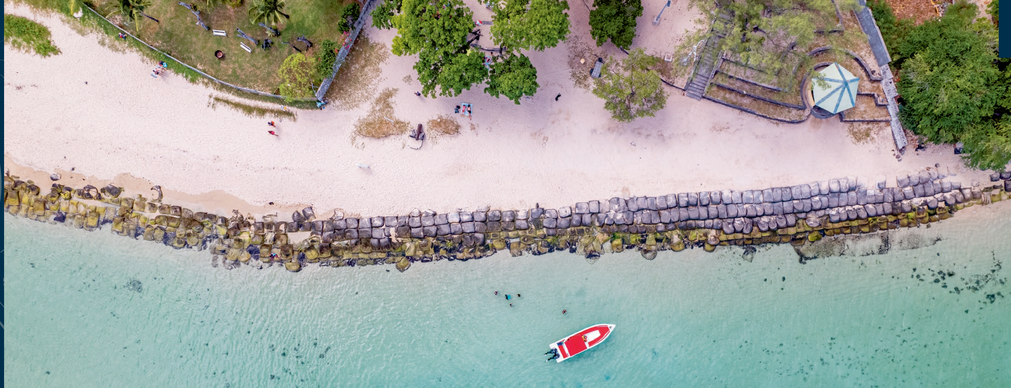
Maurice, l'érosion côtière menace les infrastructures et les habitations, un phénomène aggravé par le changement climatique. (© Eshveen Dabee - Digital Kites / AFD)
